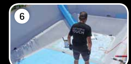
6 Boden stumpf oder überlappend verlegen.
