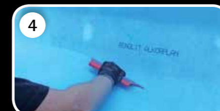
4 RENOLIT ALKORPLAN Vlies anbringen, im Fall von Osmose mit Blasen und Flüssigkeit.
