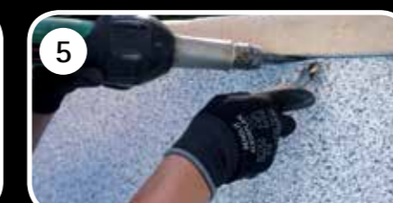
5 Wände mit RENOLIT ALKORPLAN TOUCH auskleiden.
