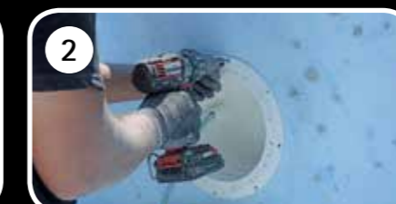
2 Einbauteile tauschen.
