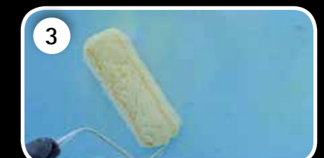
3 RENOLIT ALKORGLUE Kontaktkleber vollflächig auftragen.
